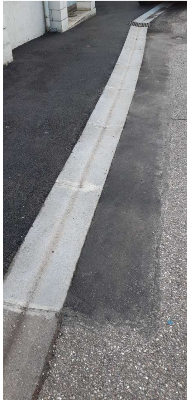
Réalisation d'un caniveau rue du Château Bas à Bazencourt
